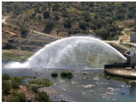
Descarregador da barragem de Alqueva (Salto de ski)
