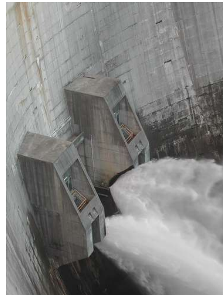
Barragem de Castelo de Bode
