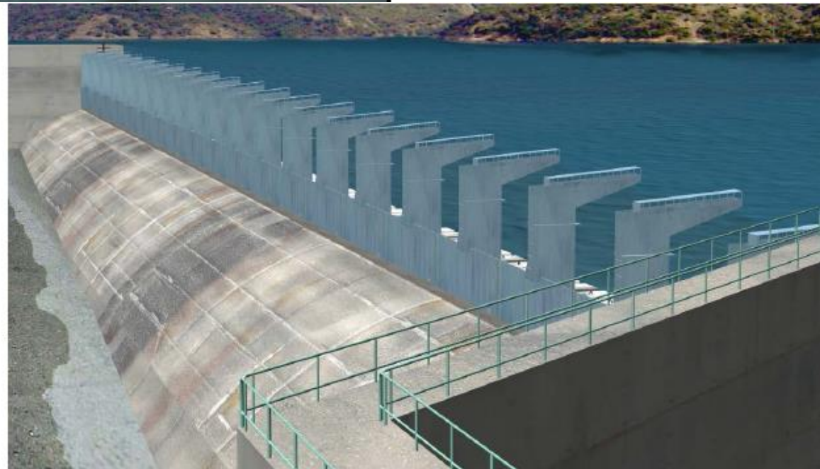
Σχ. 5: Πλευρική όψη από κατόντη της στέγης του υπερχειλίστη Καστρακίου, με τα Raygates τοποθε
