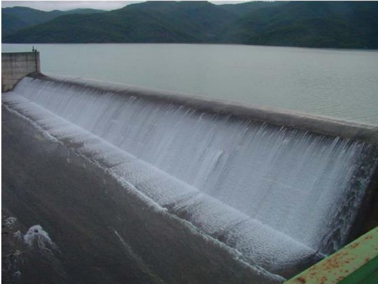
Κατασκευή εισόδου Υπερχειλιστή (L=120 m)
