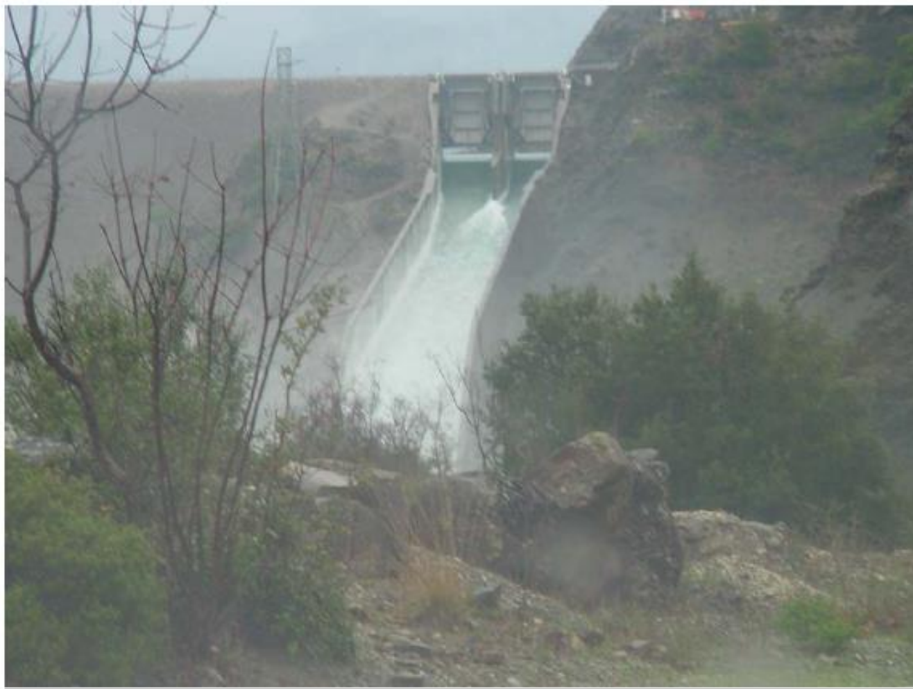
Θυροφράγματα και διώρυγα πτώσης από κατάνη (πλημμύρα 12/2005)
